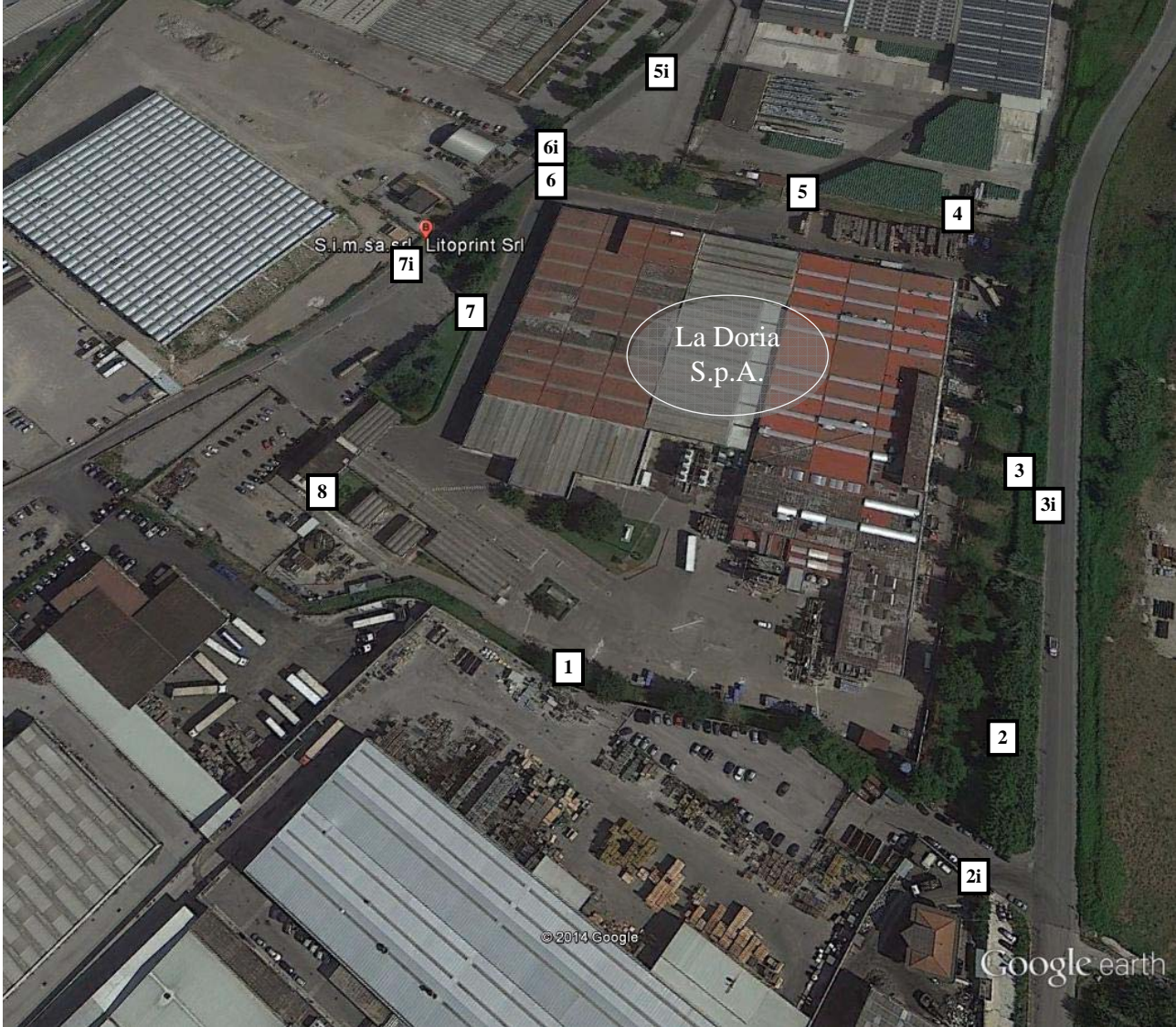
Figura 3: Vista dall'alto dello stabilimento con evidenziati i punti di misura.
